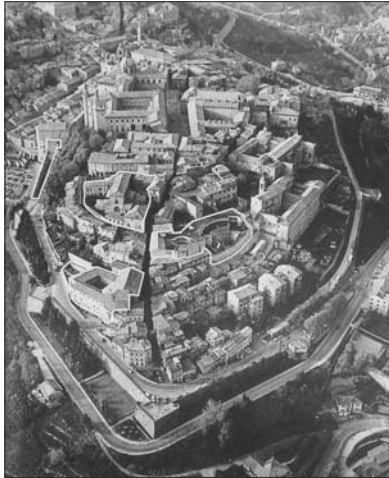
Vue aérienne d'Urbino. Les bâtiments avec des interventions de GDC sont entourés de lignes blanches.
