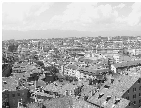
Paysage des toitures de la ville (photo MBA)
