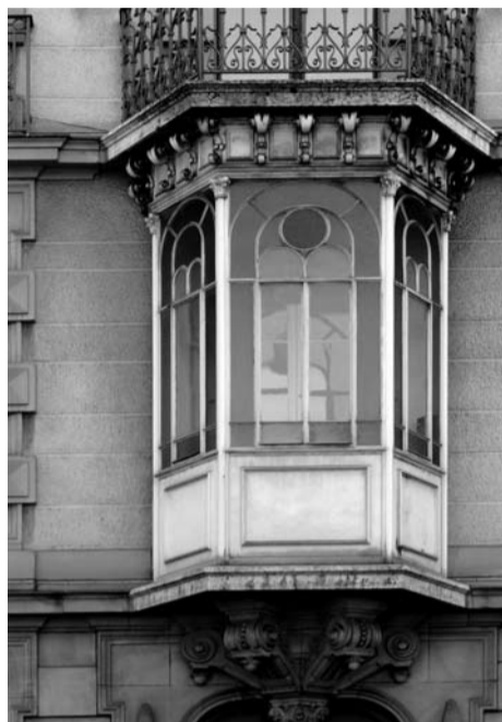
Boulevard des Tranchées 16 Hôtel particulier
