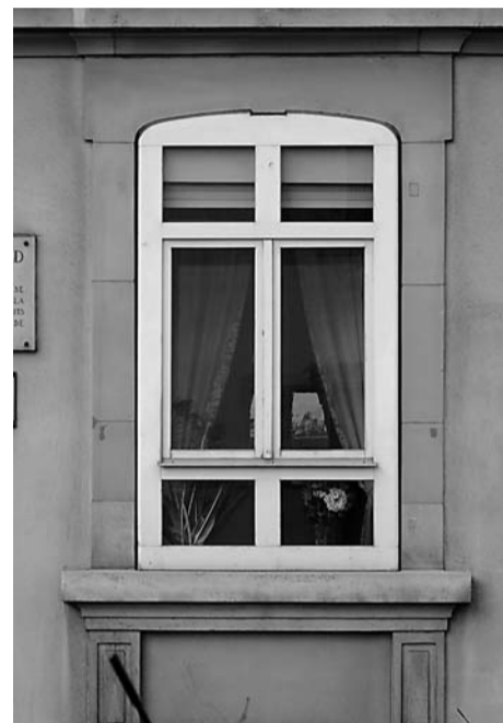
Rue Emilie-Gourd 6 Immeuble de logements
