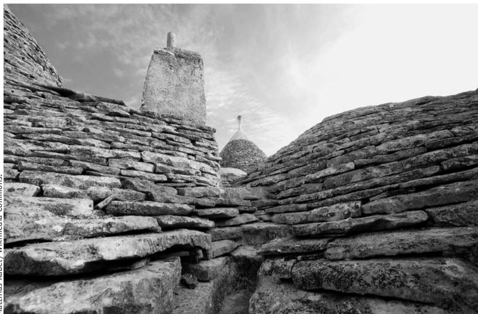
Trulli. Entre deux toits de lauzes, chenal pour l'évacuation des eaux de pluie.
