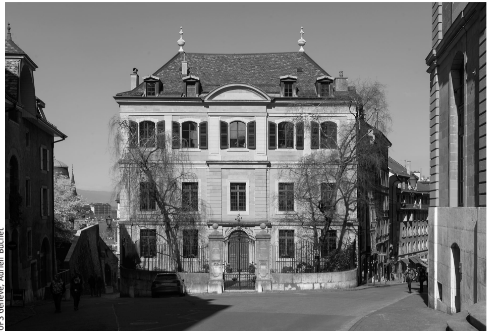
Façade principale de l'église luthérienne.
