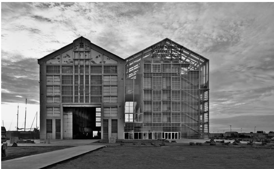
Reconversion de l'ancienne halle à bateaux de Dunkerque pour le FRAC Grand Large-Hauts-de-France.
