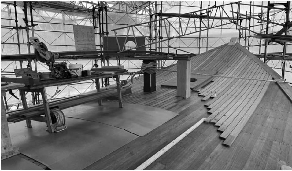
Le pont de la Neptune en reconstruction.
