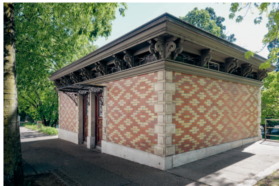
Chalet de nécessité (1898), boulevard James-Fazy / promenade de Saint-Jean.
