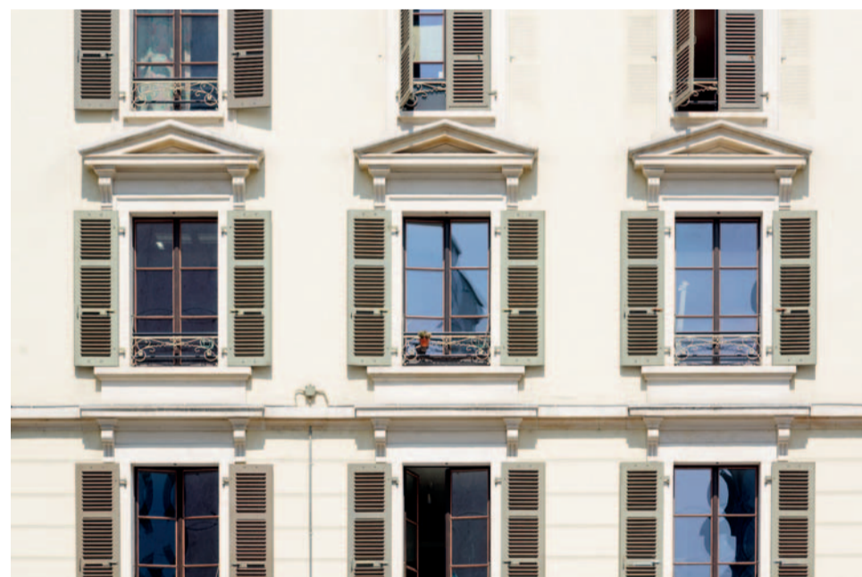
Immeuble de logements et commerces (1898), 14, rue Rousseau. Architectes: Gédéon et Louis Dériaz.
